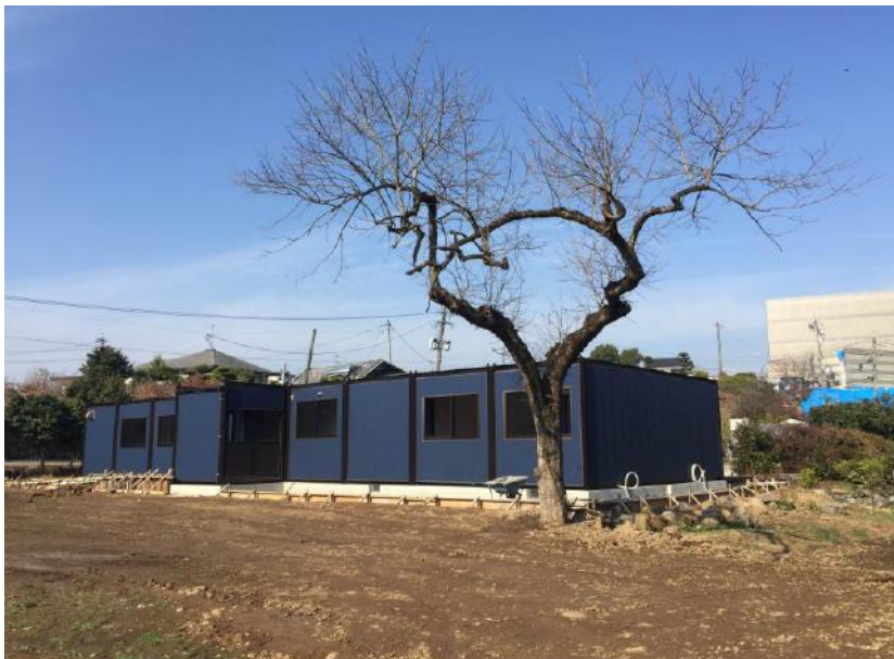
益城町に建設移転中の 「被災地障害者センターくまもと」
